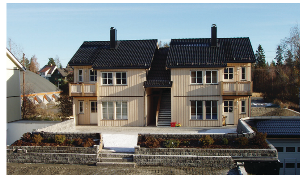
Sameiet i Aasmund Vinjes vei 10 på Lørenskog satset på varmesentral med varmepumpe og vannbåren varme. Det har gitt beboerne høy bokomfort og forutsigbare energiutgifter. Foto: Sibos AS
